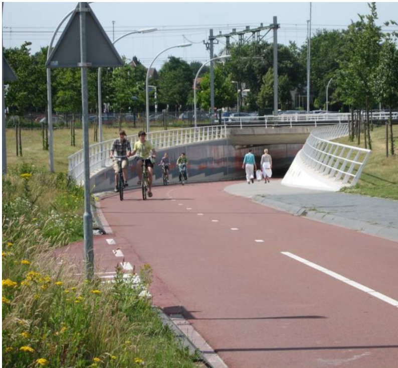
So wie hier in Zwolle (Niederlande) sollen Radschnellwege idealerweise aussehen: möglichst kreuzungsfrei, breit und mit eigenen Wegen für Fußgänger. Foto: Ulrich Kalle /
